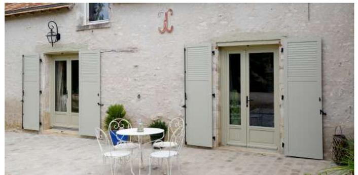
Les modèles à lamelles fixes permettent de se protéger des rayons du soleil et des regards indiscrets tout en profitant de la lumière extérieure et de ventiler la pièce.
