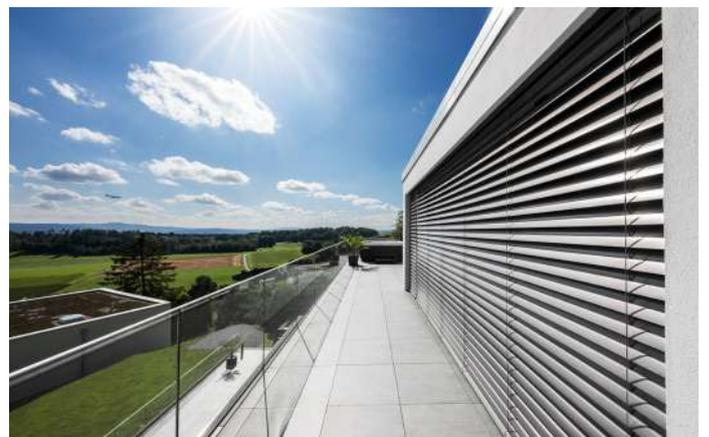
Les **BSO** traditionnels sont préconisés avec des lames en Z (modèle VR90) pour garder un joint sur les lames apportant une bonne occultation et un «silence» de fonctionnement.
